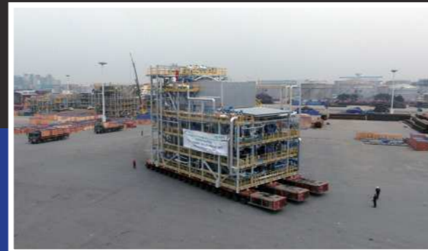
▲SPMT 운송장비에 탑재돼 부두로 이송되고 있는 웰크론강원의 산업용 스팀 보일러 모듈
