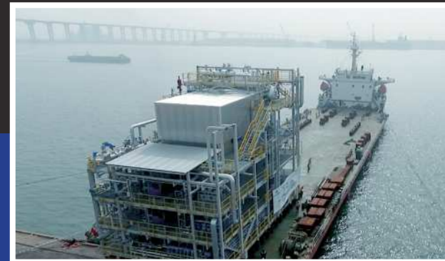
▲웰크론강원이 알주르 정유공장 건설 프로젝트에 납품하는 산업용 스팀 보일러 모듈을 선박에 싣고 있다
